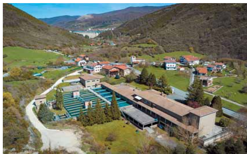
Vista de la planta potabilizadora de Urtasun. Al fondo, la presa del embalse de Eugi.
