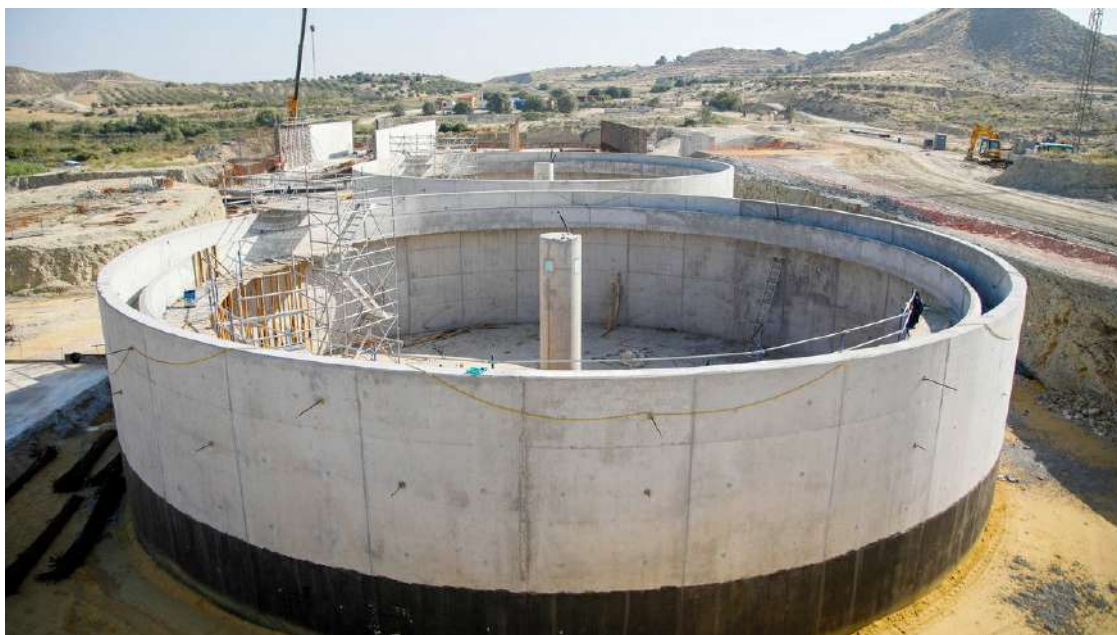
Obras de la nueva Estación Depuradora de Aguas Residuales (EDAR) de Mojácar, Almería, a junio de 2025. | Marian León (Europa Press)
